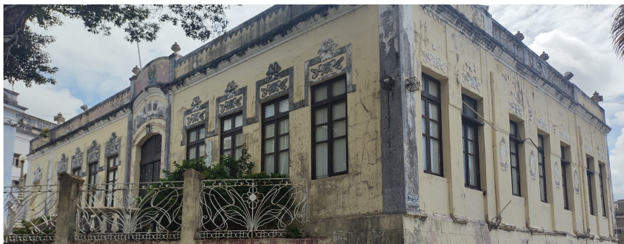
Antigo prédio da OAB-RN – 4º Sede do Tribunal de Justiça do Rio Grande do Norte (1938).
